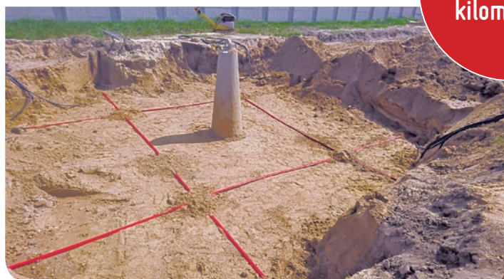
Pomiar przemieszczeń pionowych gruntu — prace badawczo-rozwojowe
