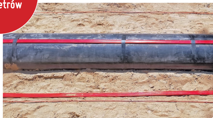
Instalacja czujnika 3DSensor wzdłuż gazociągu
