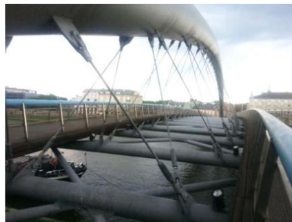
Rys. 4. Utwierdzenie rury głównej i pomostów w fundamencie oraz widok połączenia wieszaków z rurą główną oraz poprzecznicami
