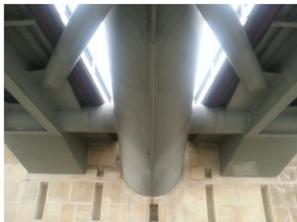
Rys. 4. Utwierdzenie rury głównej i pomostów w fundamencie oraz widok połączenia wieszaków z rurą główną oraz poprzecznicami
