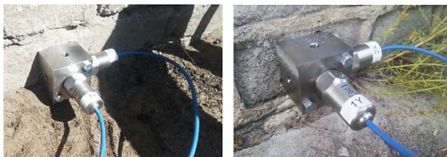
Rys. 3. Widok przykładowych punktów pomiarowych, w których mierzono przyspieszenia drgań (fot. R. Sieńko)
