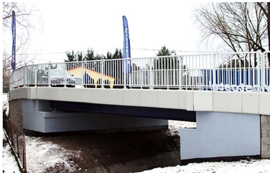
Rys. 3. Widok mostu kompozytowego
