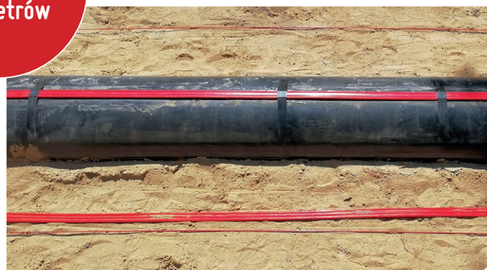
Instalacja czujnika 3DSensor wzdłuż gazociągu
