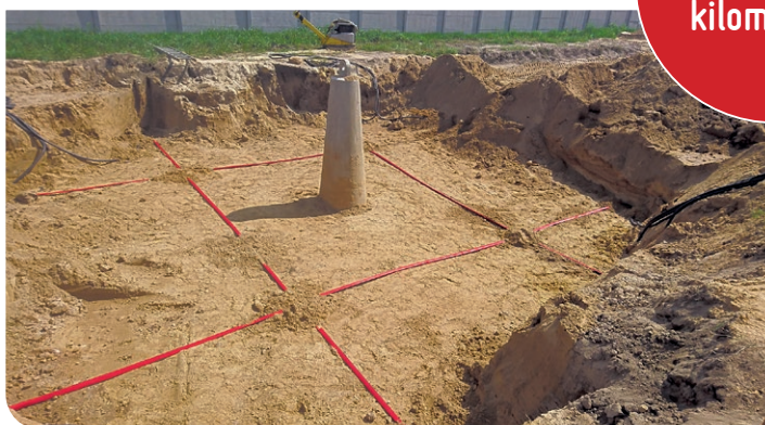
Pomiar przemieszczeń pionowych gruntu — prace badawczo-rozwojowe
