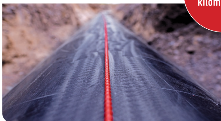
Instalacja czujnika EpsilonRebar w obrębie gazociągu
