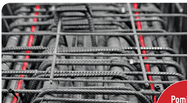
Belka sprężona betonowa z czujnikami EpsilonRebar
