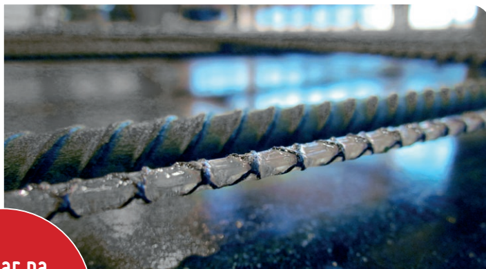
EpsilonSensor w stropie żelbetowym (konstrukcja płytowo-stupowa)
